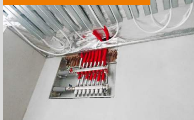
01 Rozdělovač stropního vytápění
